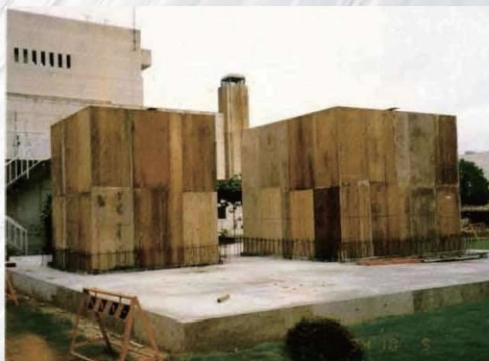
BKUプレート張り付け前の型枠
