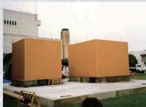
張り付け完了したBKUプレート
