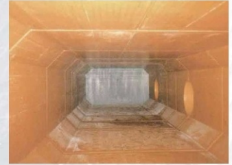
施工完了後の内面
