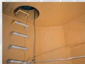
マンホール及びステップ取り付け部
