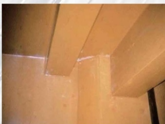
壁・梁・天井部
