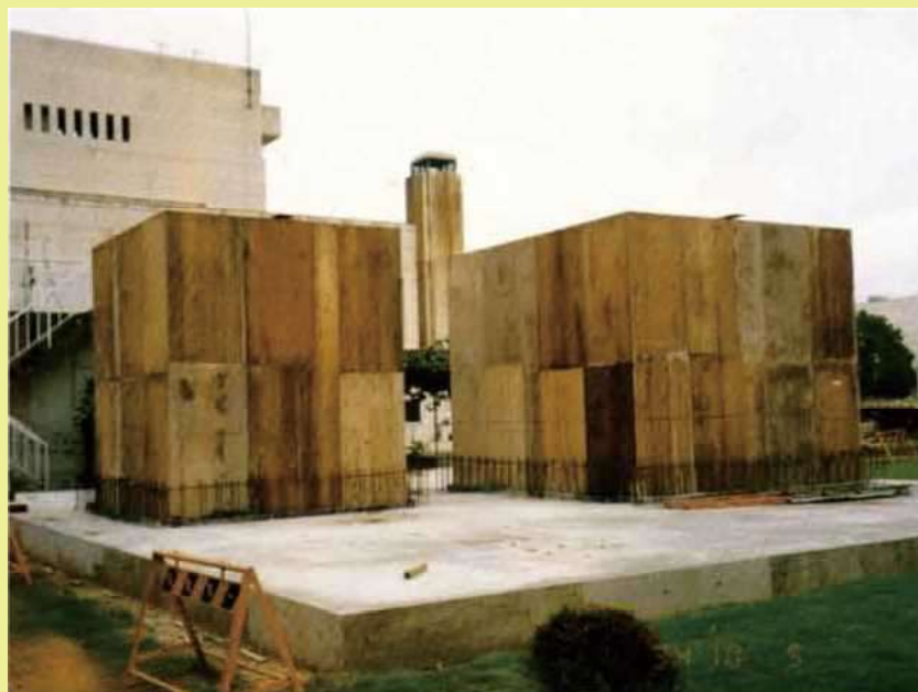
BKUプレート張り付け前の型枠
