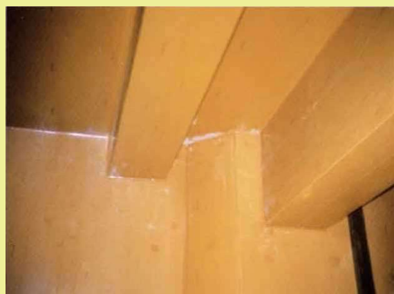
壁・梁・天井部
