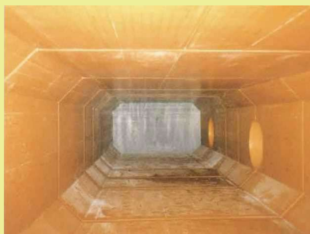
施工完了後の内面
