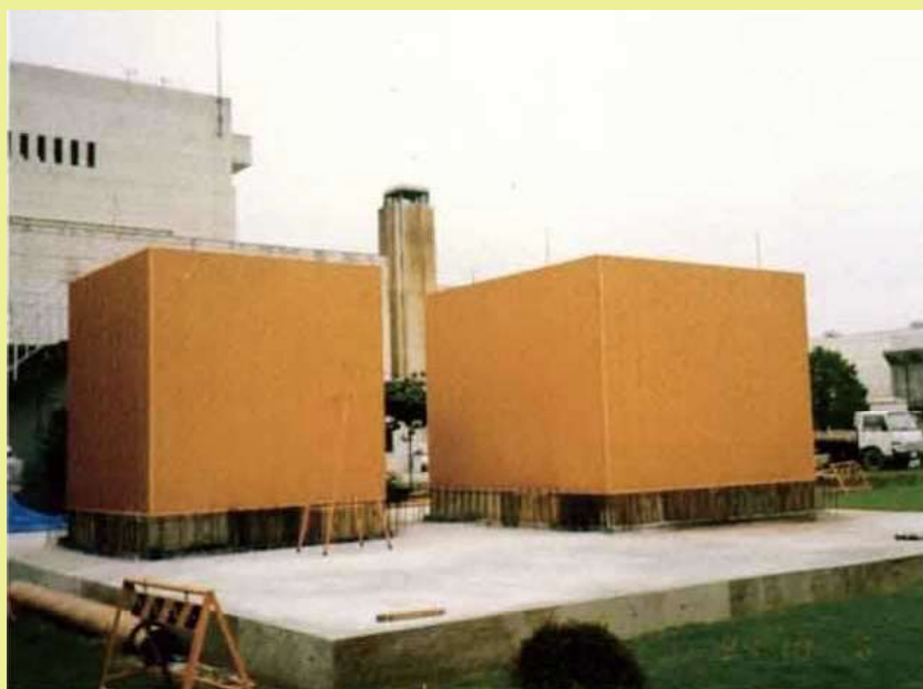
張り付け完了したBKUプレート
