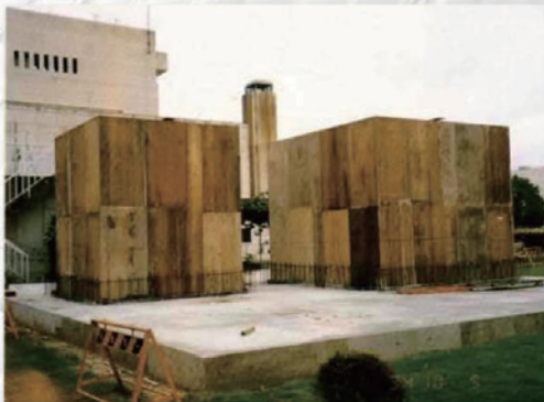
BKUプレート張り付け前の型枠
