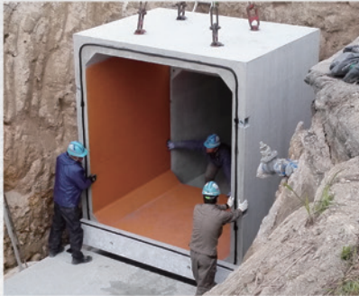
BOXカルバート落差孔
