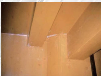
壁・梁・天井部
