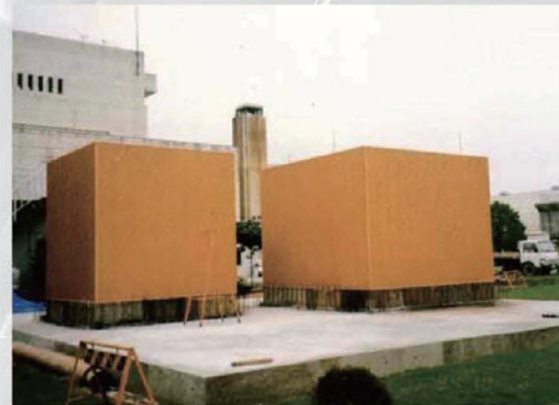
張り付け完了したBKUプレート
